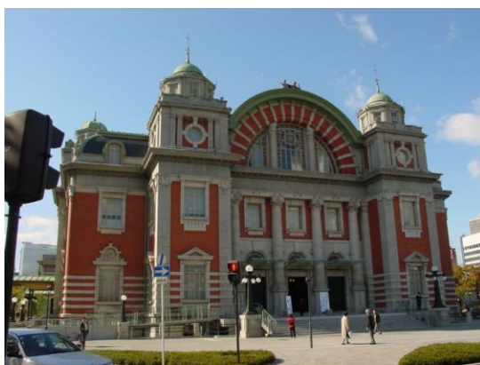
写真1 免震構造の例（大阪中央公会堂，1918年竣工，2002年に免震レトロフィット）
