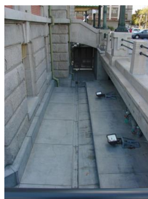
写真1 免震構造の例（大阪中央公会堂，1918年竣工，2002年に免震レトロフィット）
